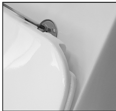
06 Stringere il fissaggio. Tighten the fixing screw.
